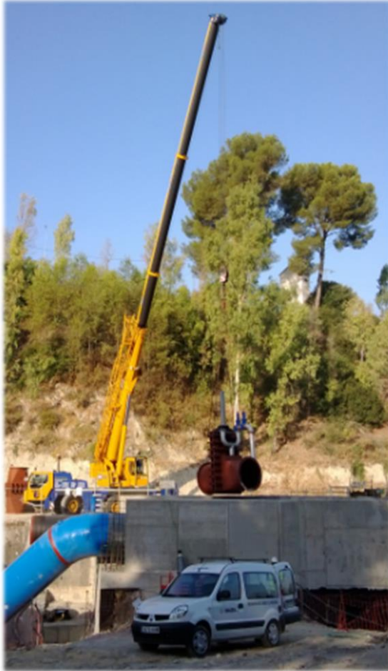
Compuerta Bureau presa de Torre del Águila. Montaje en obra.
