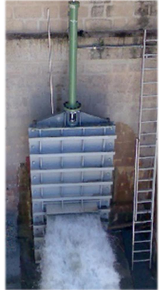
Compuerta Bureau para la central hidroeléctrica de Mengibar. Maniobras de puesta en marcha.
