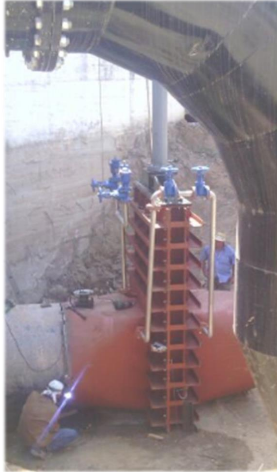
Compuerta Bureau Balsa N. S. Los Dolores. Montaje en obra.
