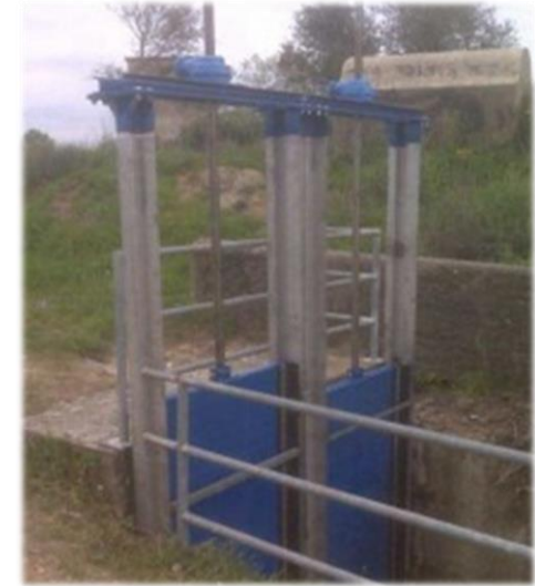
Compuertas deslizantes instaladas en el canal III-A de los riegos del Árrago en Cáceres para la Confederación Hidrográfica del Tajo.
