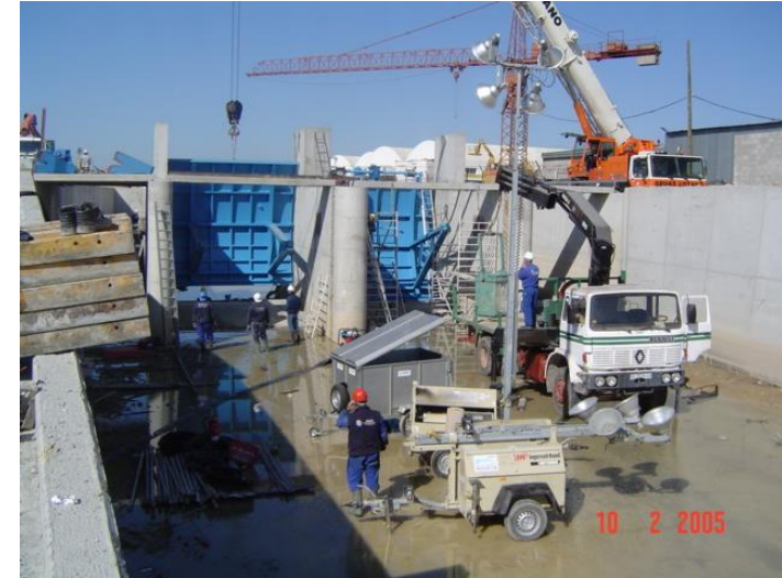
Montaje de compuertas Taintor en Torreblanca (Sevilla)
