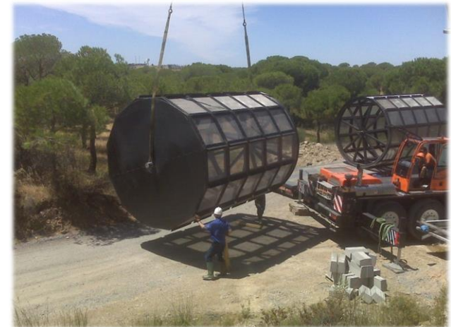
Filtros rotativos instalados en La Subzona Oeste de la Zona regable del Chanza
