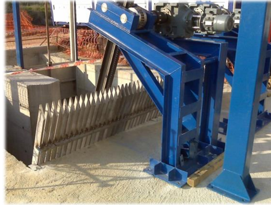
Limpiarrejas lineal en el la balsa de La Gitana. Confederaci3n Hidrogr'afica del Guadalquivir.
