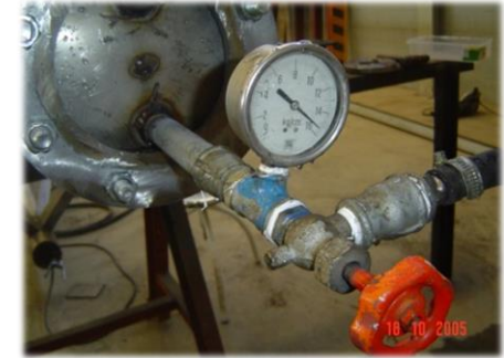
Toma flotante Castilblanco de los Arroyos Prueba de presión Embalse de Cala (Sevilla)
