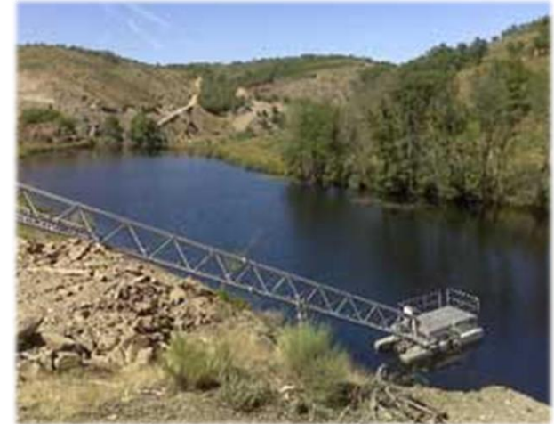
Toma flotante Rebollar Oeste Embalse de Iruña (Salamanca)
