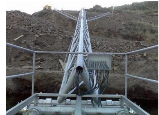
Toma flotante Rebollar Oeste Embalse de Iruña (Salamanca)
