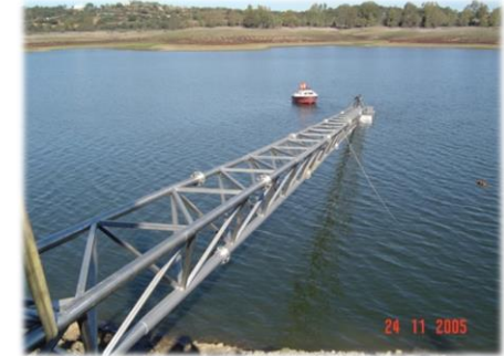
Toma flotante Castilblanco de los Arroyos Proceso de montaje Embalse de Cala (Sevilla)
